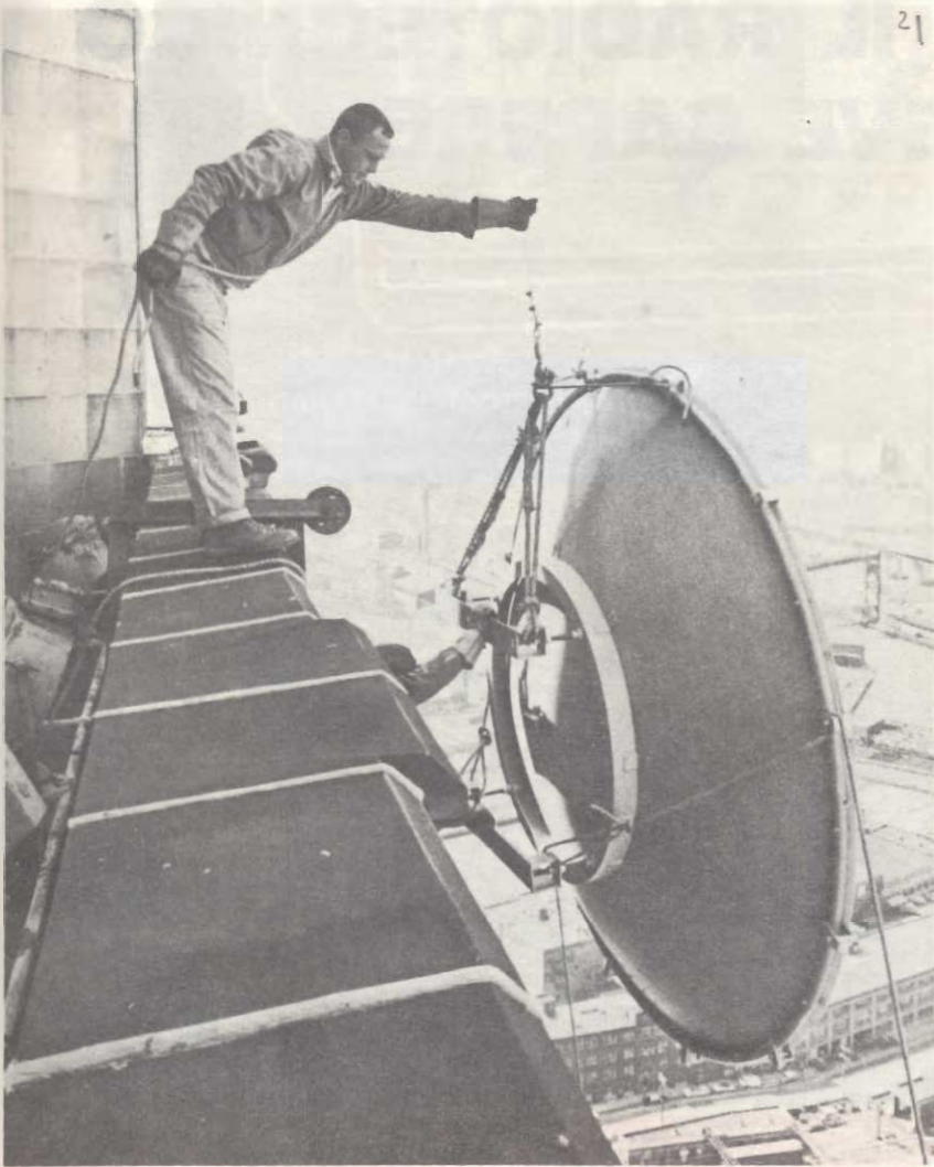
Fig. 2 - Installare un'antenna parabolica a 100 m di altezza? Ma è una cosa semplicissima, basta non soffrire di vertigini!
